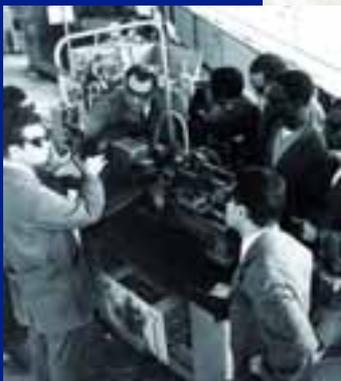
Cours au Centre de formation de Turin, février 1969. Un instructeur polyglotte explique le fonctionnement d'un tour automatisé moderne monté sur un système électropneumatique, un modèle utilisé dans la fabrication de composants pour l'industrie automobile.
