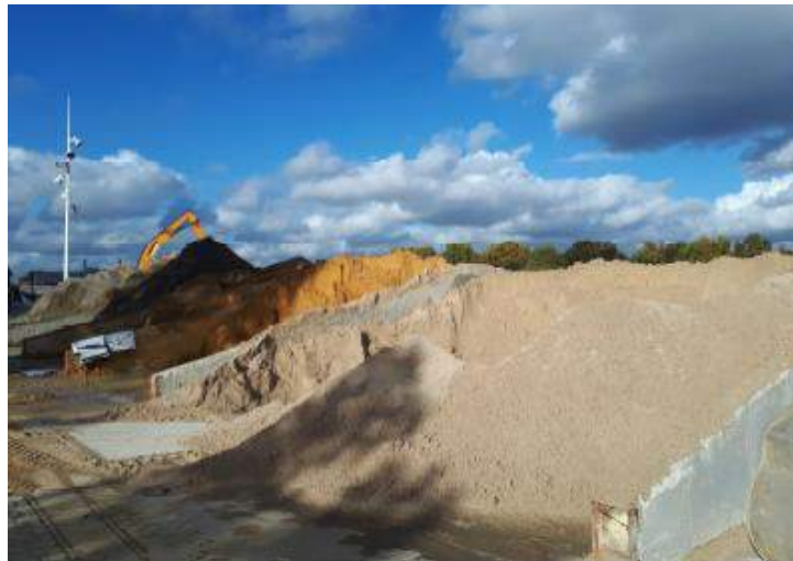
Photos de la plate-forme d'Aubervilliers (6 novembre 2019).
