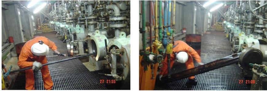
Figure 2 : Insertion et lancement du PIG – Source : Remiro, 2009
