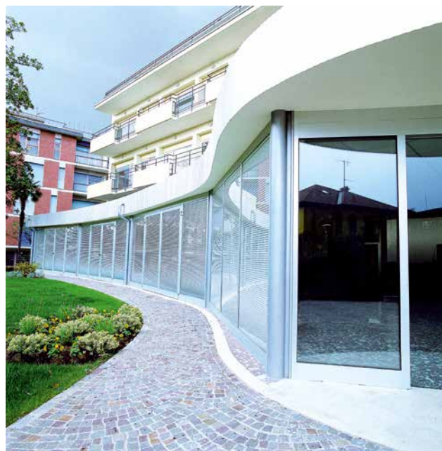
▲ Les doubles vitrages avec stores intégrés CLIMAPLUS® SCREEN à la Villa Barbarano, Brescia, Italie
