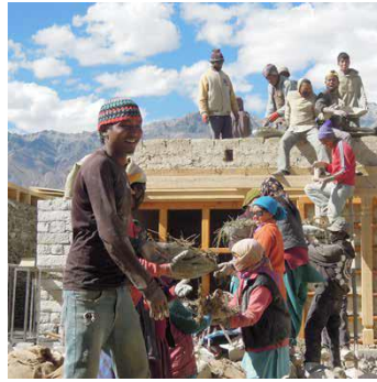
Construction d'une école au Zanskar, Inde
