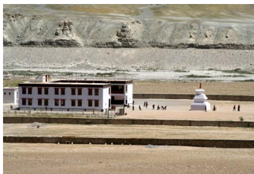
École au Zanskar avec Architectes Sans Frontières
