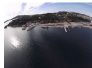
Vue de l'espace Joseph Grimaud en travaux (Toulon Provence Méditerranée)
