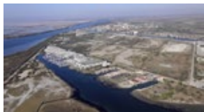
Vue aérienne de Port-Saint-Louis-du-Rhône (ville de Port-Saint-Louis-du-Rhône)
