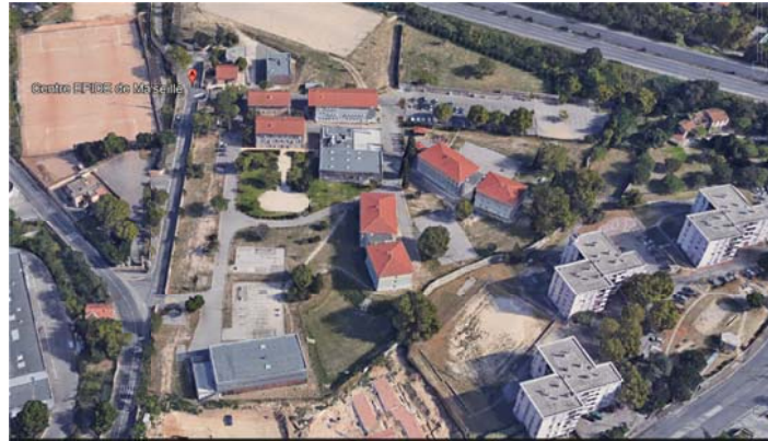
Vue aérienne Centre Epide Marseille (Google Earth)
