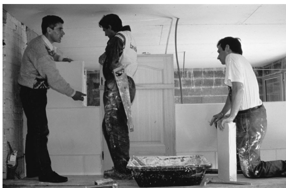
Formation en situation de travail en maçonnerie.
