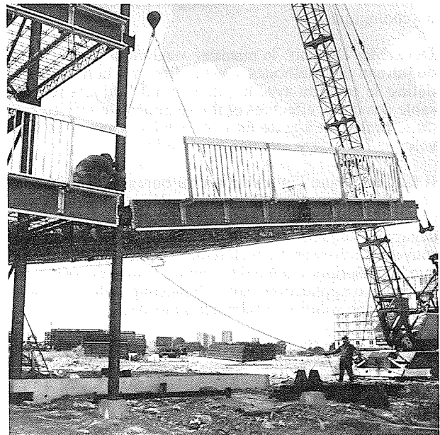
Construction industrialisée (système de construction M. Lods-GEAI). Ce système n'utilise le béton que pour les fondations. Ici mise en place d'un élément de « plancher » en treillage métallique. (Photo : GEAI-CIMUR)
