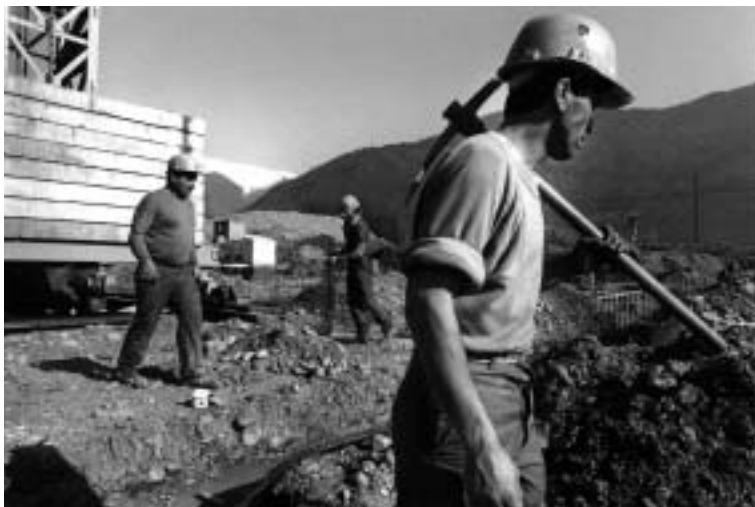
Chantier de la piscine réalisée pour les Jeux olympiques d'Albertville 1992 : maçons au travail.
