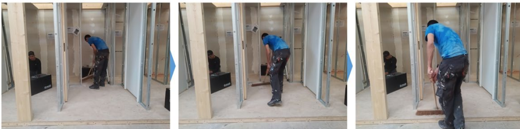
Le nettoyage de la cabine individuelle
