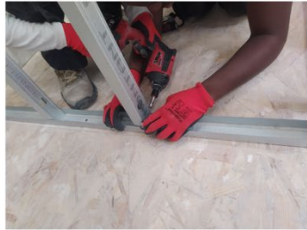
2. Vissage de l'ossature métallique
