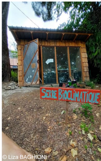
Serre bioclimatique construite par le collectif de travail.
