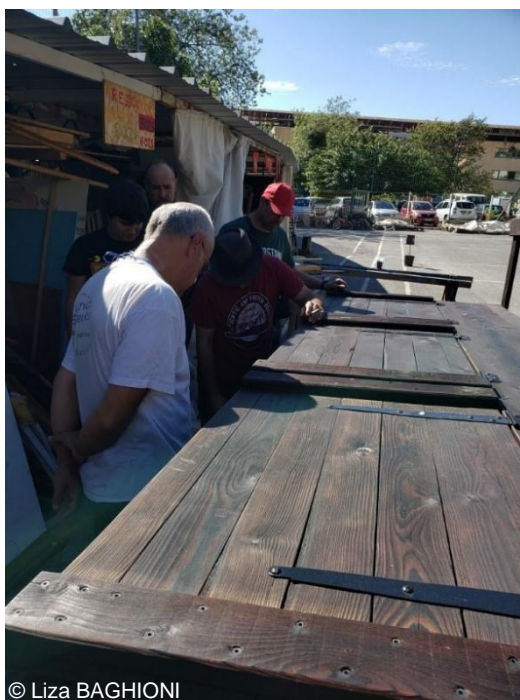
Construction d'un compost trois bacs.
