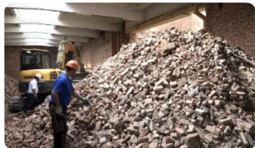
Démolition et réemploi sur site. Rénovation de la Tour A Plomb, Bruxelles. © BVDA - Bernard Van Damme Architecte
