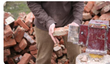
Nettoyage mécanique des reste de mortier
