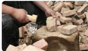
Nettoyage manuel des reste de mortier
